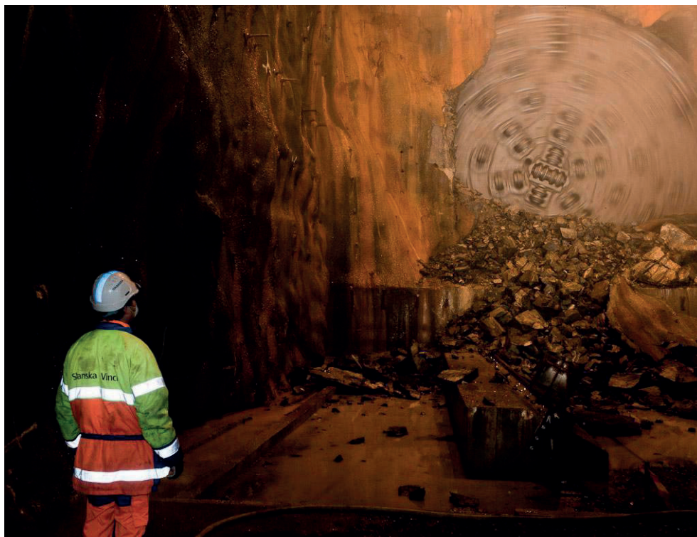
Figur 7 Genombrott i det östra tunnelröret.
