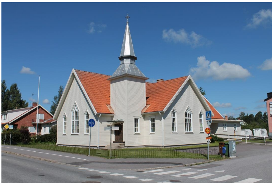
Fastigheten Giraffen 13, korsningen Västra Drottninggatan-Skomakaregatan
