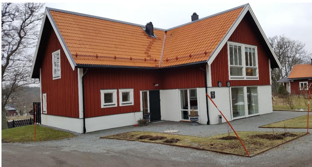
Figur 20. Befintlig byggnad som har uppförts som mindre avvikelse från D203.
