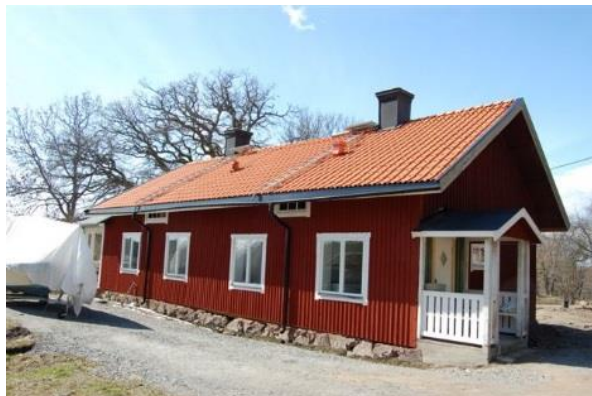
Figur 28. Byggnad 3 (Foto: Susanne Eschricht, kommunantikvarie)
