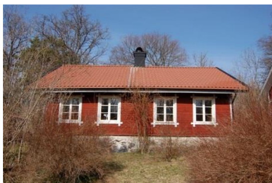
Figur 27. Byggnad 2 (Foto: Susanne Eschricht, kommunantikvarie)
