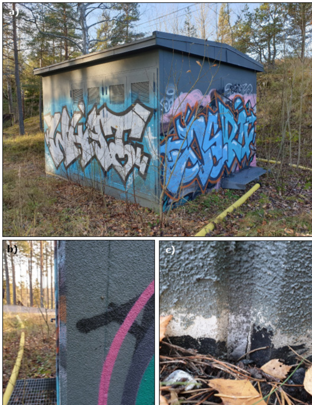
Figur 23. Elcentralen (a), en övertäckt fog (b) samt en öppen fog där fogmassa kan ses (c).
