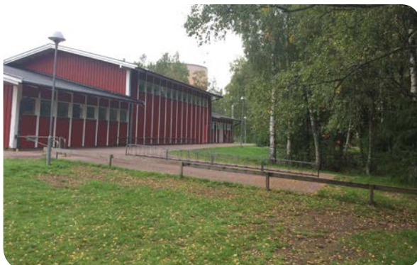
Cykelparkering på östra sidan av gymnastiksalen
