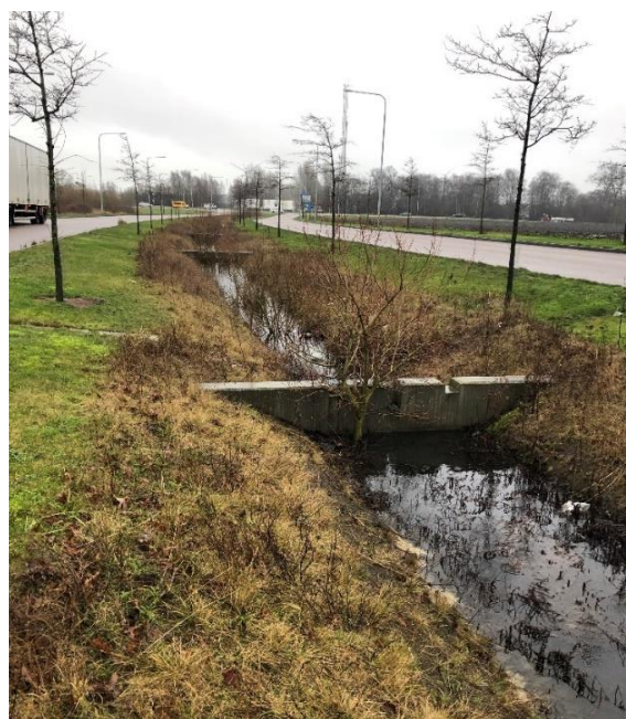
Infartsgata från Österleden med sektionerat dike. Foto: NIRAS
