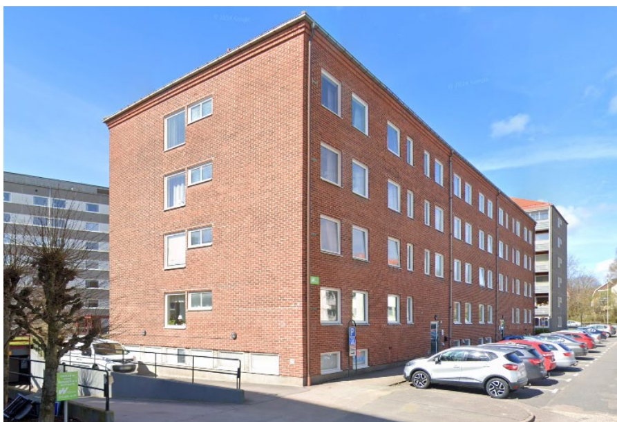
Bild: Befintligt 4-våningshus på Backhausgatan som tillhör fastighet Biet 5. Bild från Google maps.
