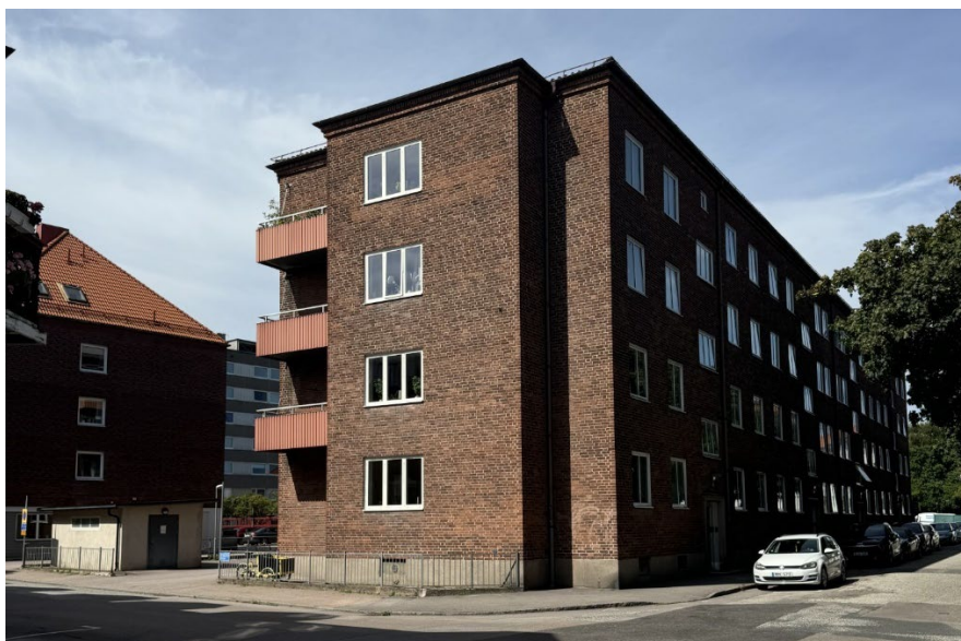
Bild: Befintlig C-klassad byggnad på fastighet Biet 3. Bild: Eget taget foto av planhandläggaren.
