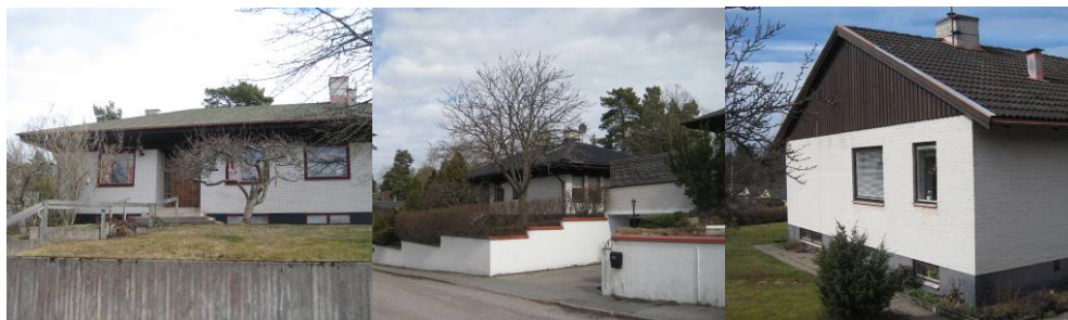
Byggnader i karaktärsområdet "Grupphusen"
