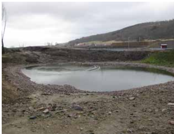
Damm strax norr om Stensån
