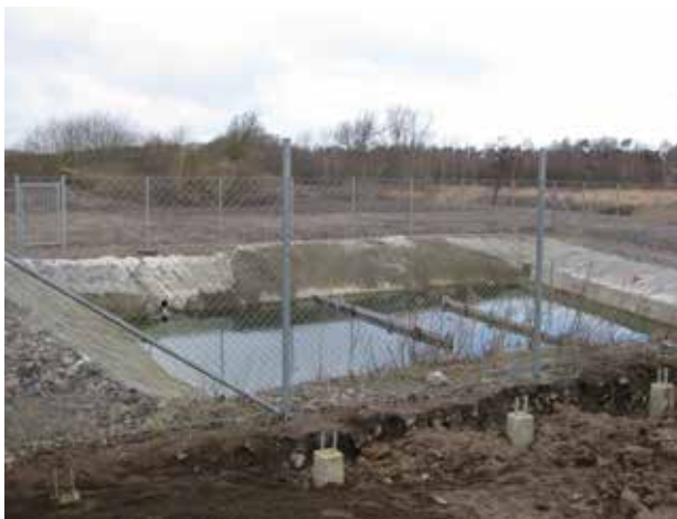
Trafikverkets damm för provtagning av dagvatten från Hallandsåstunneln
