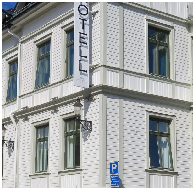
Bild 11: Byggnadens fasader ska vara av trä och färgsättas med ljus kulör likt befintliga förhållanden. Fasadens utförande ger uttryck för den då moderna sågverksindustrin som möjliggjorde liggande spontad panel som på klassicistiskt vis användes för att dela in fasaden i fält med våningsband, omfattningar och fasadpanelens riktningar. Val av kulör, kvalitet samt matthet ska bedömas utifrån en god helhetsverkan. Plastfärg kan därmed anses vara olämpligt.
