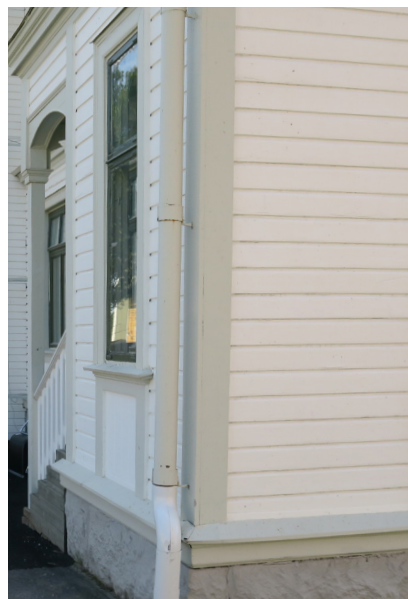
Bild 11: Byggnadens fasader ska vara av trä och färgsättas med ljus kulör likt befintliga förhållanden. Fasadens utförande ger uttryck för den då moderna sågverksindustrin som möjliggjorde liggande spontad panel som på klassicistiskt vis användes för att dela in fasaden i fält med våningsband, omfattningar och fasadpanelens riktningar. Val av kulör, kvalitet samt matthet ska bedömas utifrån en god helhetsverkan. Plastfärg kan därmed anses vara olämpligt.
