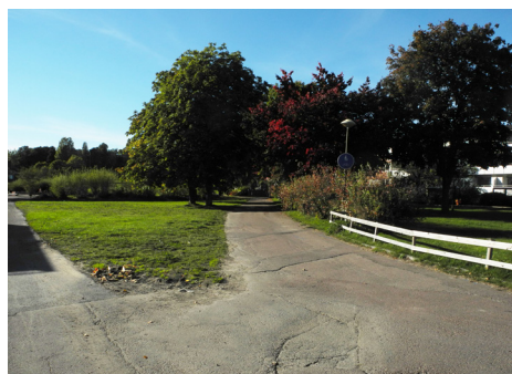
Del av nuvarande gång-och cykelväg.
