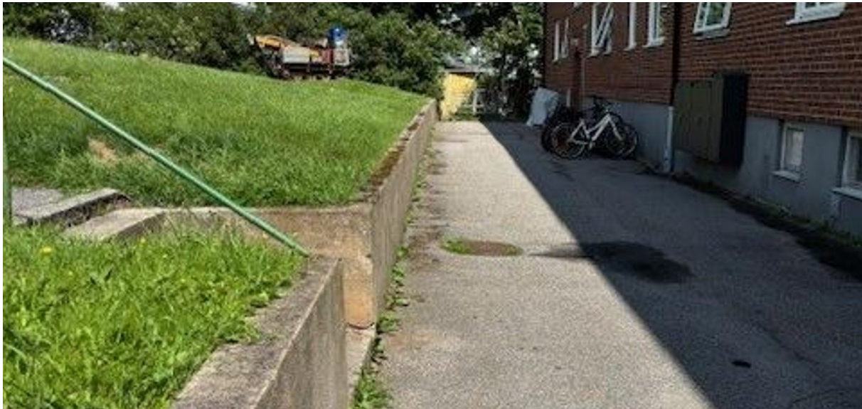
Utklipp från bild i geotekniskt PM som visar slänten vid befintlig stödmur och pågående slagsondering.
