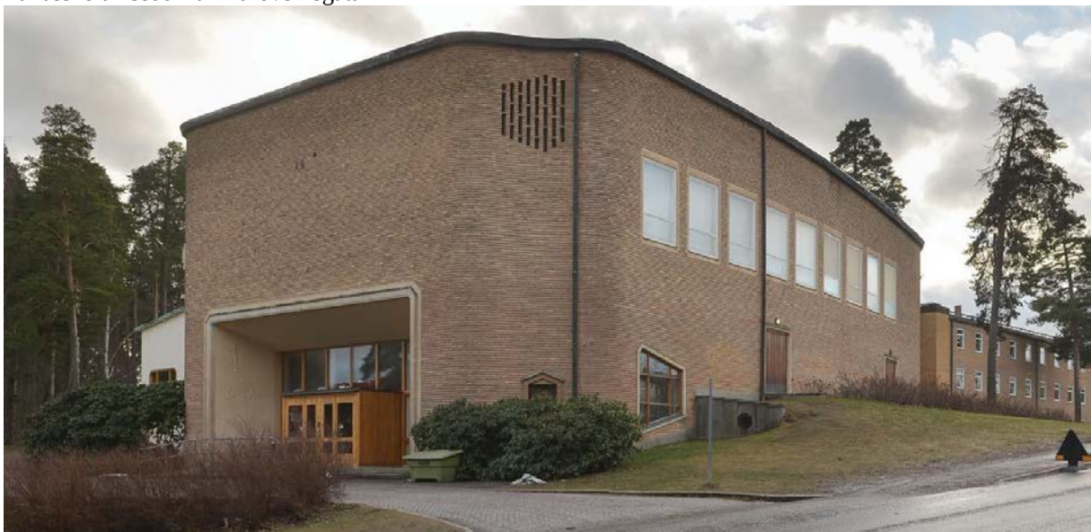
Tallåsskolans aula sedd från norr.
