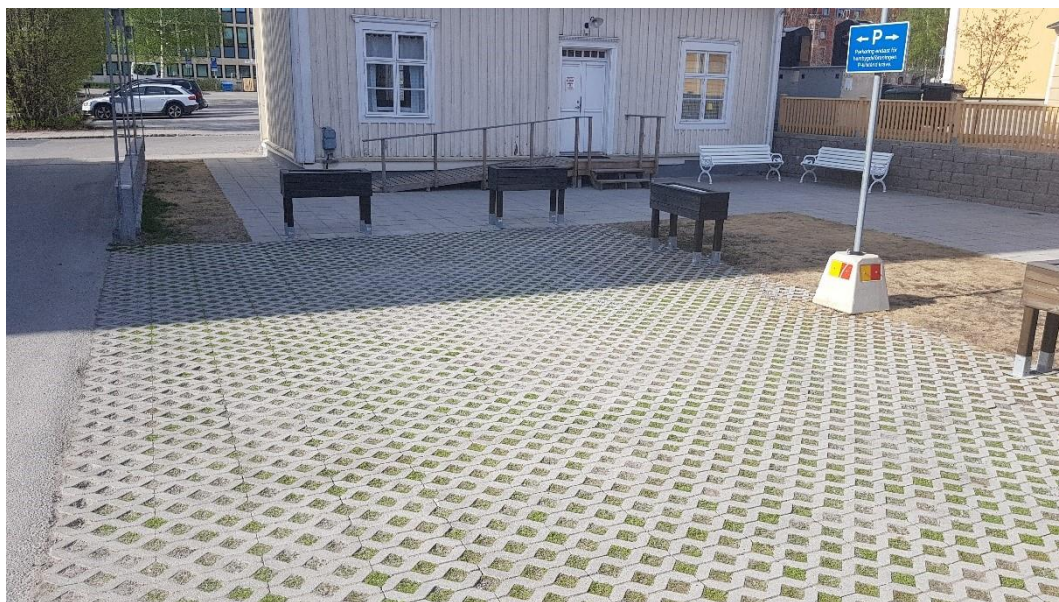
Figur 37. Genomsläpplig beläggning i form av gräsarmerad betong på parkering i Luleå. Foto: AFRY.
