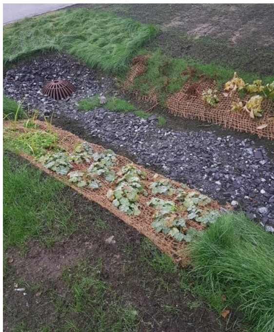
Figur 38. Makadamdike med kupalbrunn i Luleå. Foto: AFRY
