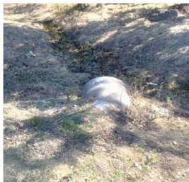
Figur 7. Foton av trummornas inlopp och utlopp.
