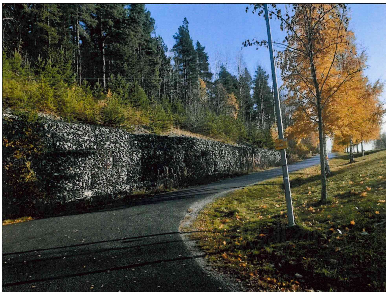
Figur 4: Bild som visar befintlig gång- och cykelväg längs väg 372 med gabionburar som stödmur. Foto: Skellefteå kommun.
