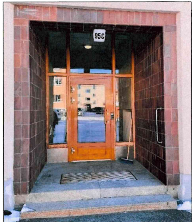
Figur 14: Ny dörr av metall med mindre glasruta.
