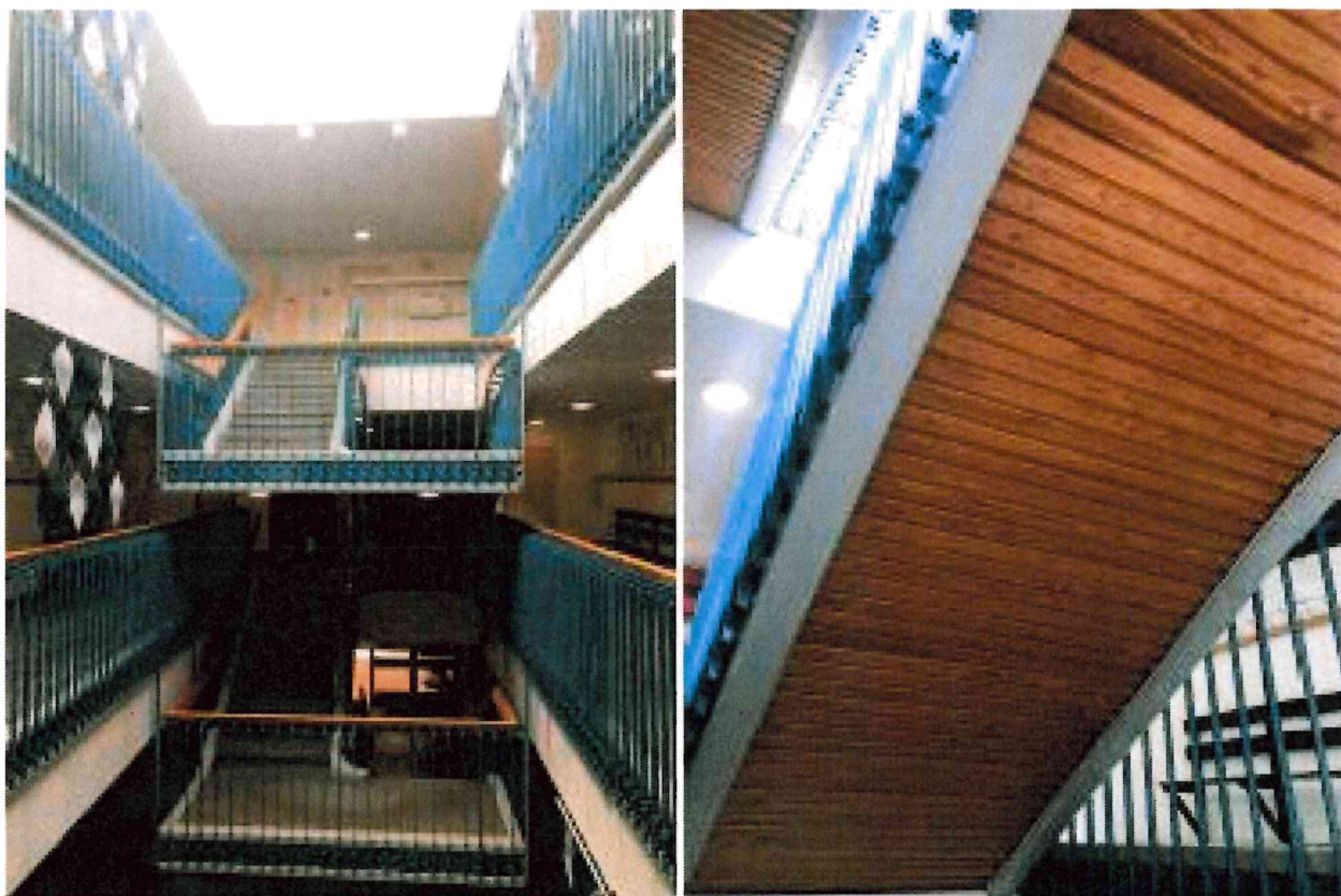
Figur 11: Trapphuset och dess lanternin.
