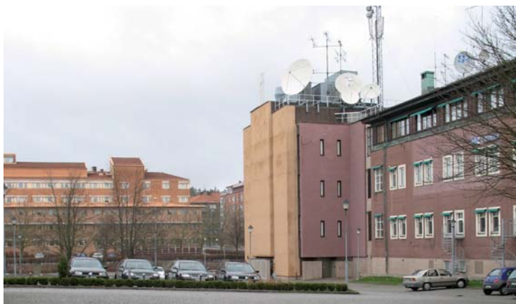
Telestationen från 70-talet med teknisk utrustning på taket.
