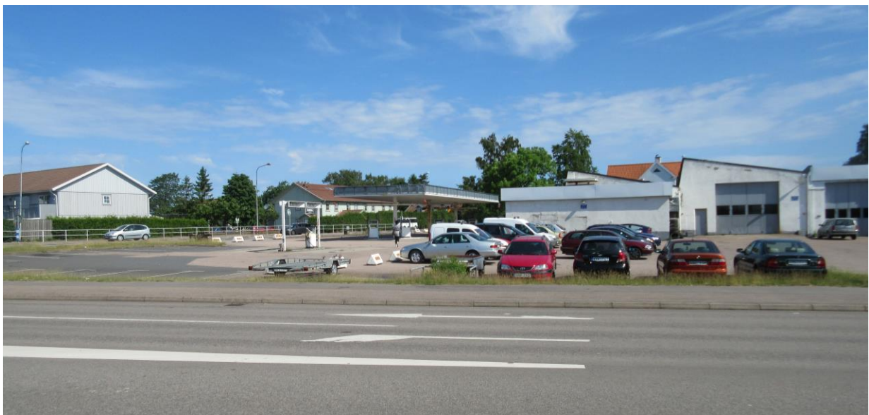
Fastigheten Äpplet 7, sett från LP Hanssons väg
