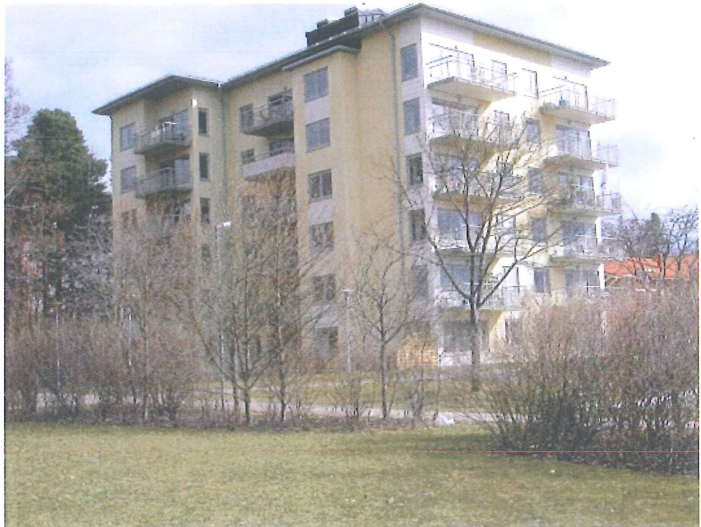
Det befintliga huset (Brf Tallen) strax söder om den plats där de nya husen föreslås.
