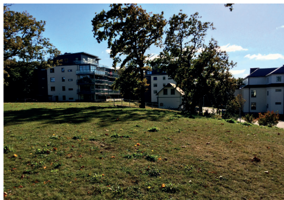
Foto: Den gamla sanatoriebyggnaden till höger och senare tillägg med flerbostadshus till vänster.
