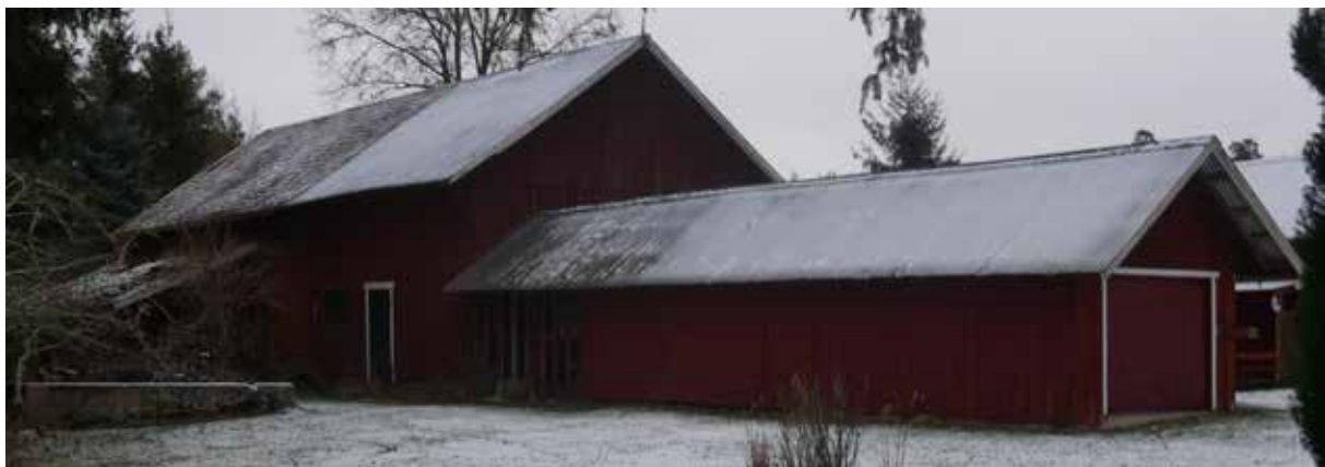
Ladugården - fasad mot norr
