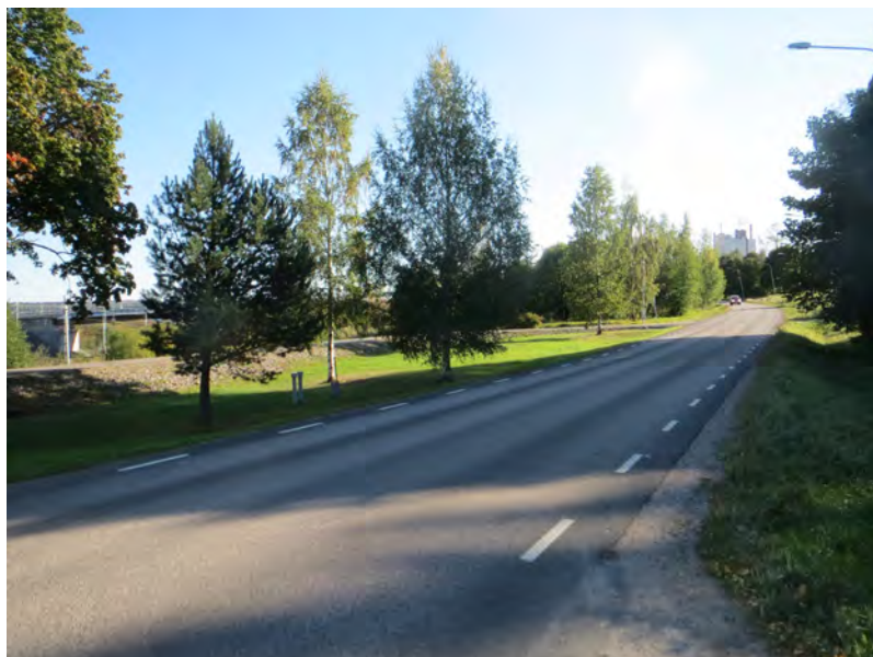
5. Från Järnvägsgatan nedanför Skolgatan
