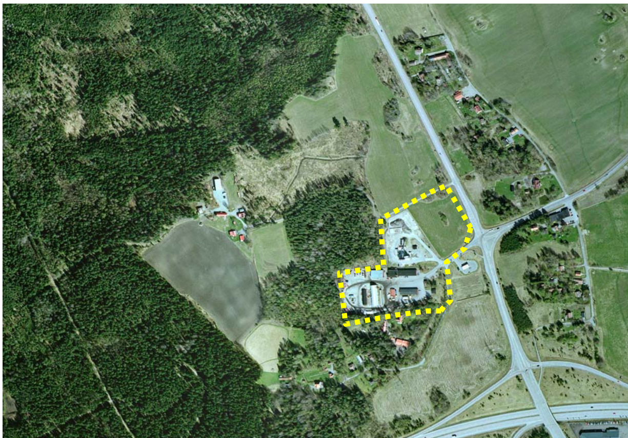
Planområdets läge intill riksväg 70 vid den norra entrén till Enköping. Copyright Enköpings kommun.
