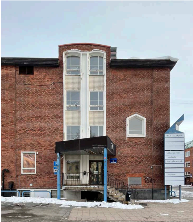
Befintligt trapphus i söder
