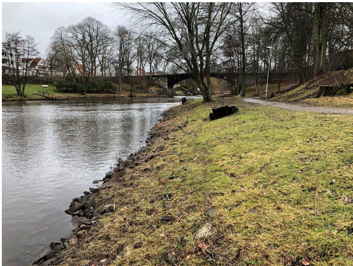
Figur 12: Strandkanten längs det aktuella området utgörs av stenar och en gräsbeklädd yta. Enligt kartunderlag från SGU och SGI är sträckan utpekad som aktsamhetsområde för skred.
