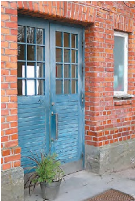
Nuvarande entrédörrar på norra fasaden. Foto 2012.
