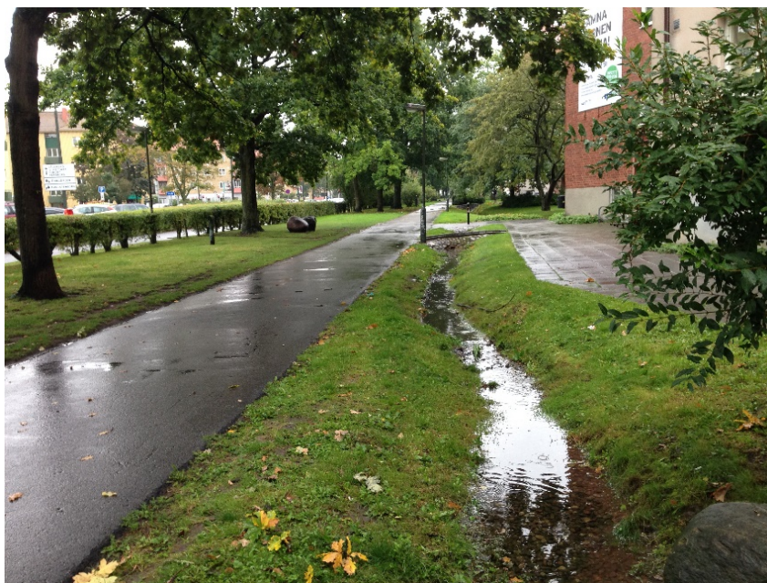
Bild ovan t.v. Förslag på en enkel variant av yttlig avrinning, via öppna diken längs gångstråk eller grönstråk till större uppsamlingsdammar.
