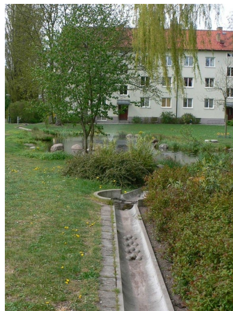
Bild ovan t.v. Förslag på en enkel variant av yttlig avrinning, via öppna diken längs gångstråk eller grönstråk till större uppsamlingsdammar.
