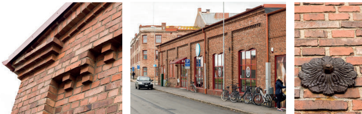
Bild 12: Befintlig snickeriverkstad med fasad och byggnadsdetaljer.
