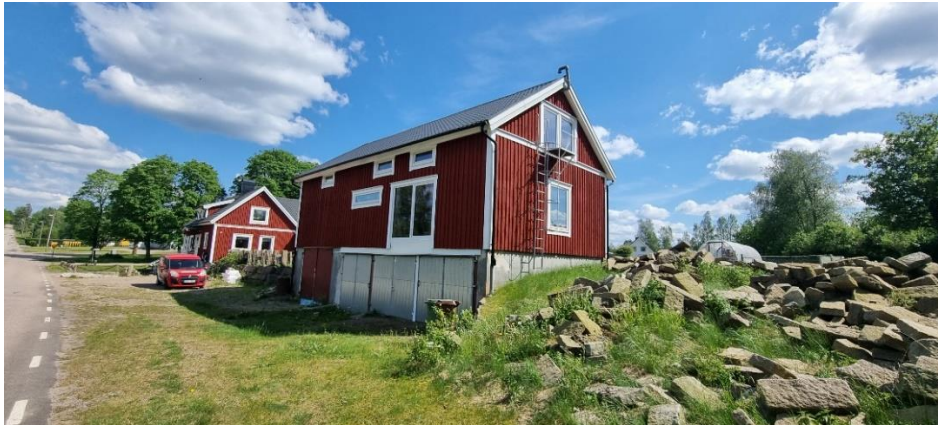
Befintlig huvudbyggnad på platsen, 2024-05-22.
