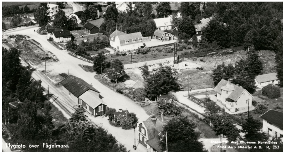
Bild 5. Flygfoto från sydväst som visar stationsbyggnaden och övriga byggnader och ytor i anslutning till stationsläget. Fotår:1936 Bildkälla: Digitalt museum.
