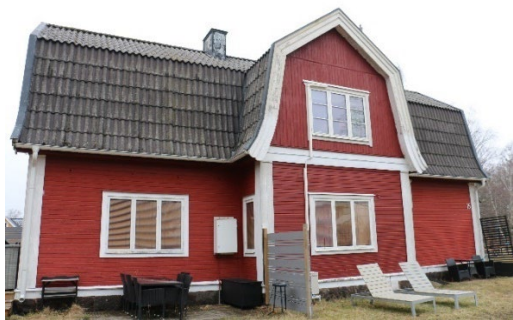
Bild 15. Byggnaden sedd från öster
