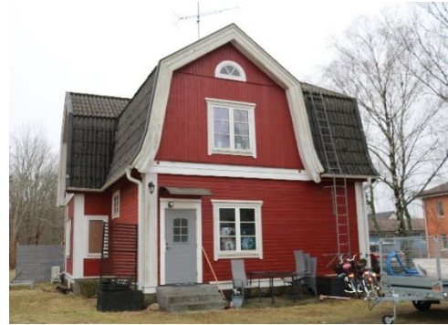
Bild 14. Byggnaden sedd från norr
