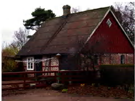
Tunneberga 3:9 uthus K2, q
