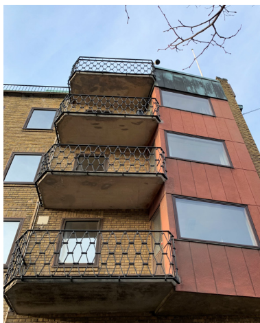
Bild 4. Fasadtegel, mönstermurning, hörnparti samt koppardetaljer vid tak.
