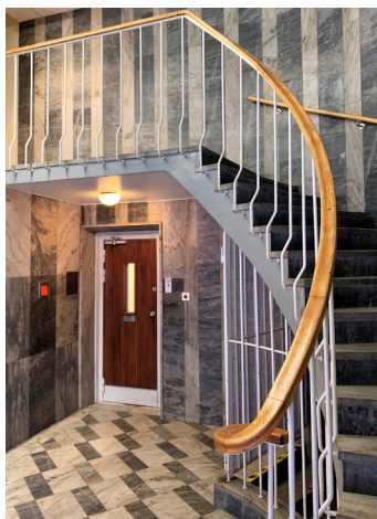
Bild 7. Trapphus mot Drottninggatan. Väggskivor samt trapplopp.
