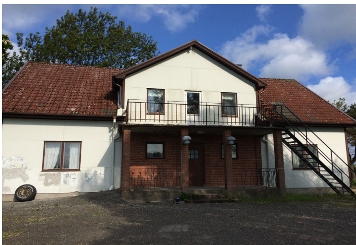
Befintlig mangårdsbyggnad tillhörande f.d. Kåtene gård.
