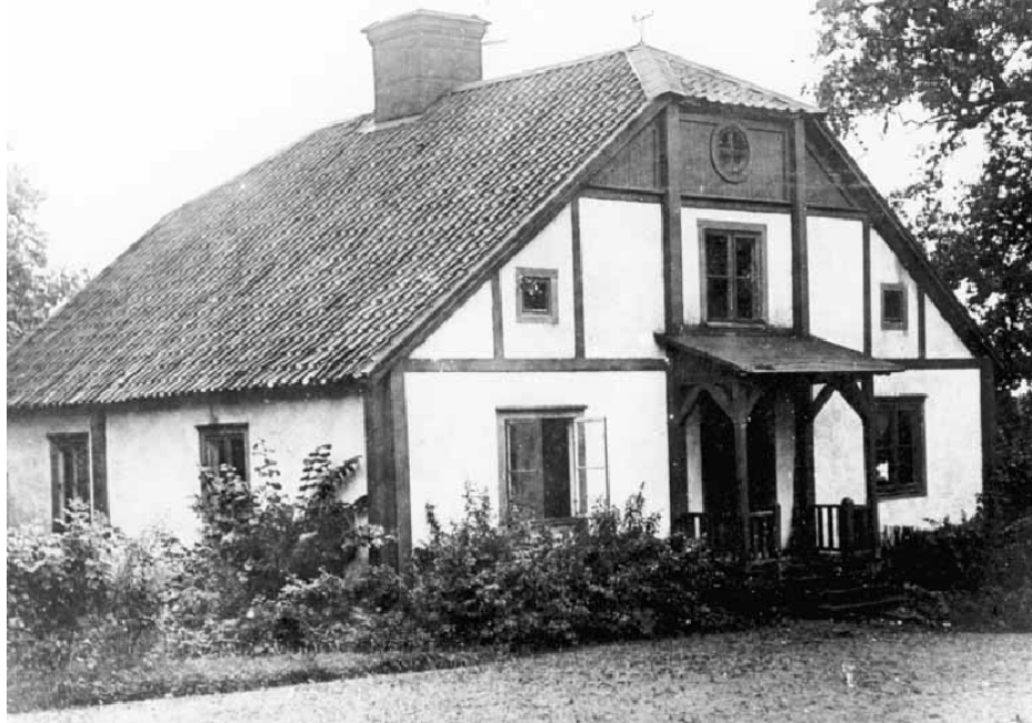
Värdefull byggnad - norra flygeln
