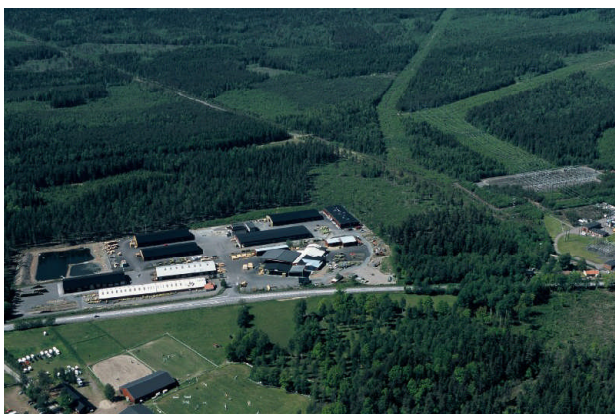
Fastigheten Stolpen 1 med impregneringsanläggningen och naturen runt omkring.
