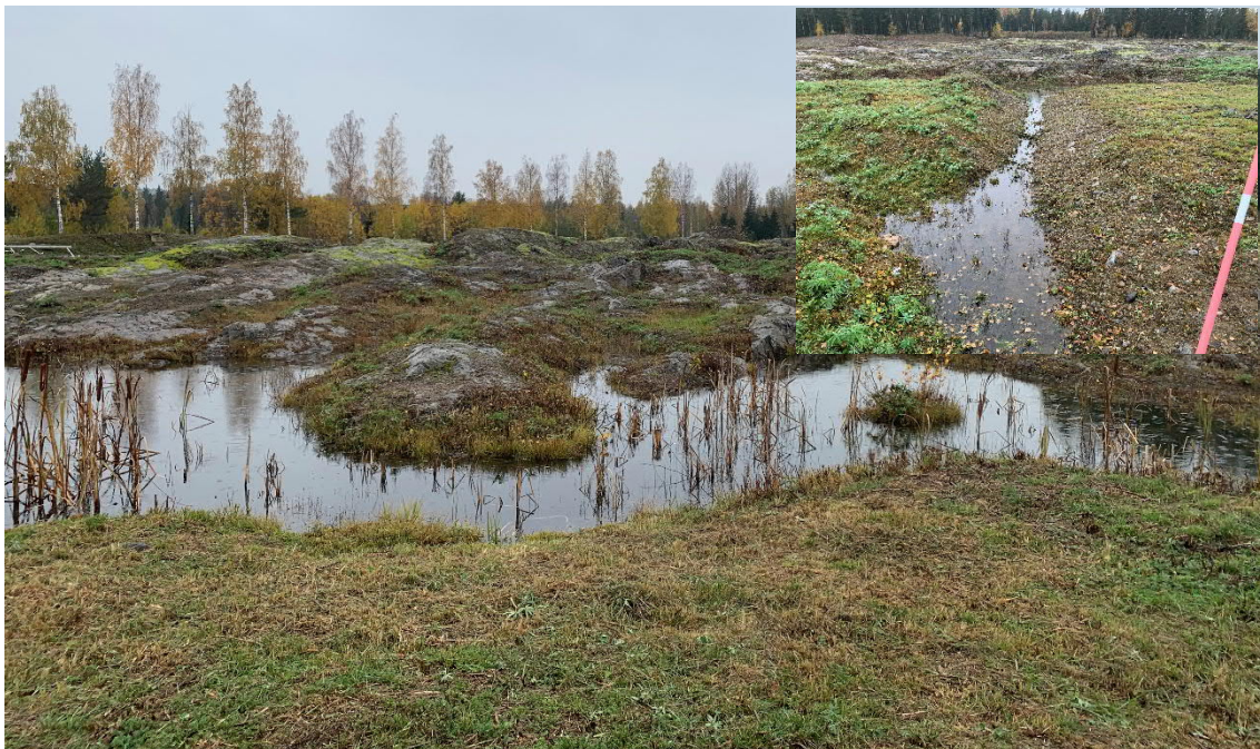
Figur 4. Ett svackdike avvattnar avtäckt berg och vattnet leds sedan vidare till ett dike som går mot sydost, se blå pilar i figur 5.
