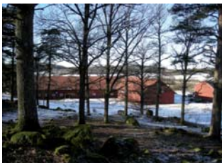
Utsikt från formlämskullar i norr över ladugård-byggnad mot ängs- och våtmarker i väster
