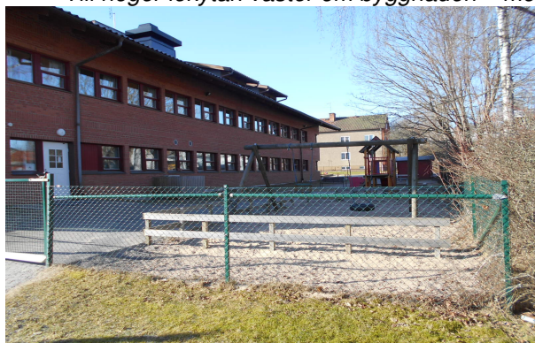
Foto: Befintlig utelekplats norr om byggnaden
