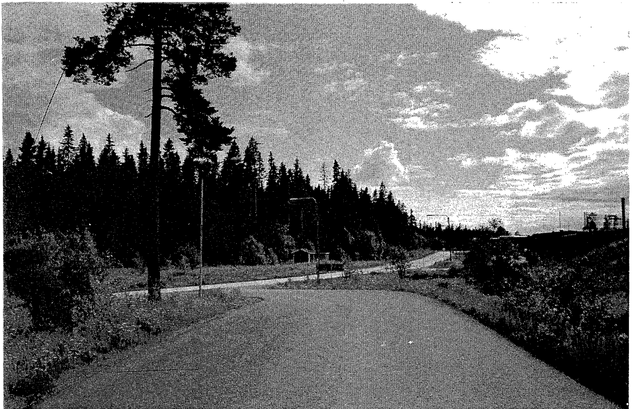
Bilden tagen mot söder utefter lokalgatan som skall byggas om, och som leder in mot Lits centrum.
