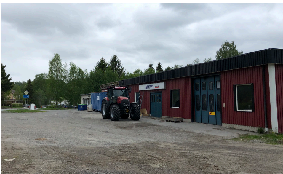
Befintlig byggnad inom Främmerhörnäs 3:3. Väg 335 (Hörnäsvägen) till vänster i bild. (Foto: Tyréns AB 6 juni 2020).
