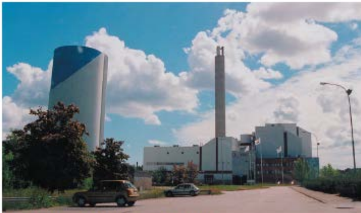
Idbäckens värmeverk, ca 200 meter söder om planområdet.
