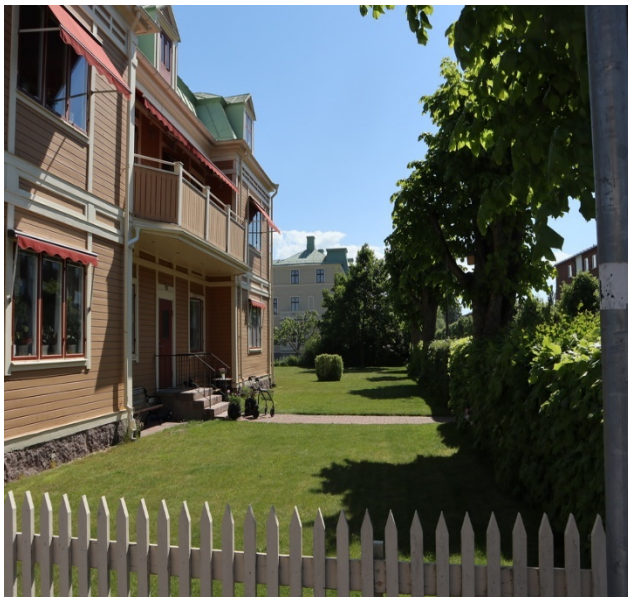
Befintligt bostadshus på fastigheten
