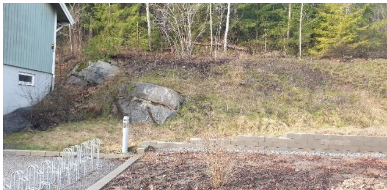
Slänt med vegetation samt berg i dagen i gränsen mellan Sparven 5 och Sparven 6. Foto: Norrtälje kommun 2020.
