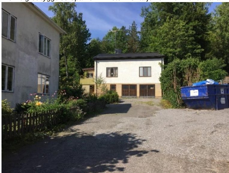
Befintlig bebyggelse Sparven 3. Foto: Norrtälje kommun 2019.
