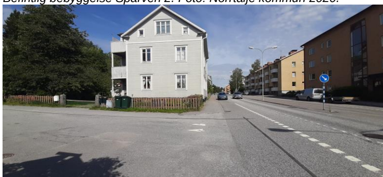
Befintlig bebyggelse Sparven 1. Foto: Norrtälje kommun 2020.
