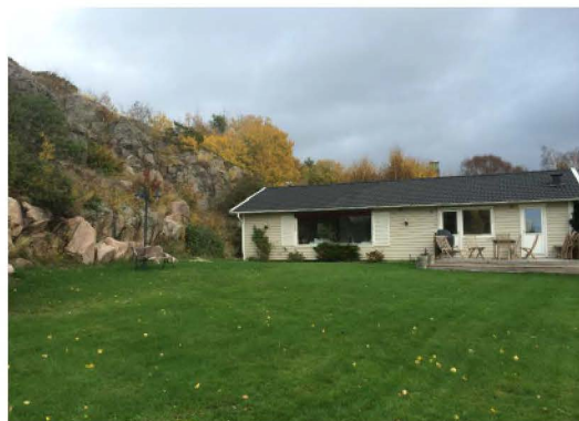
Hus på fastigheten Bukärr 22:28 som avses rivas och kompletteras med ett nytt.
