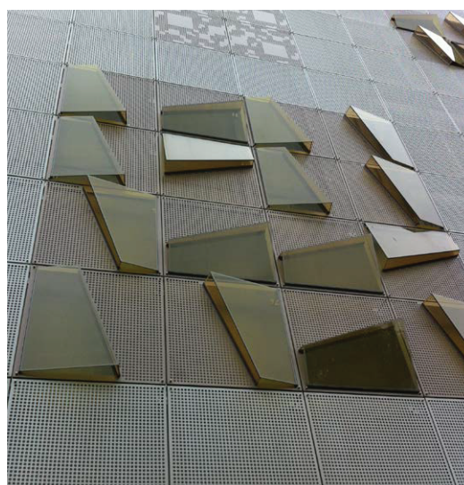
Fasadmaterial i glas och plåt på ett p-hus i Kristianstad
