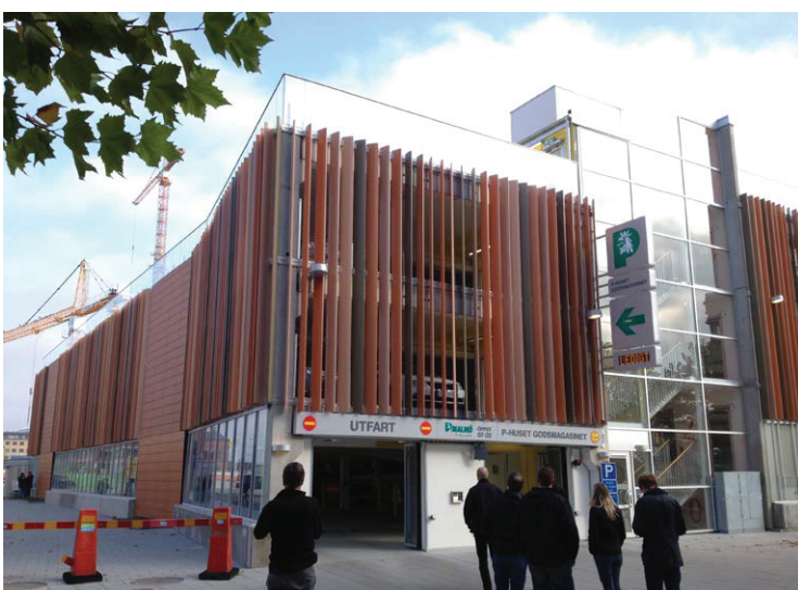
Parkeringshus i Malmö med en fasad av glas och tegelfärgade lameller
