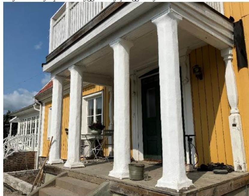
Veranda med nya pelare fram och äldre pelare bak mot fasad.
