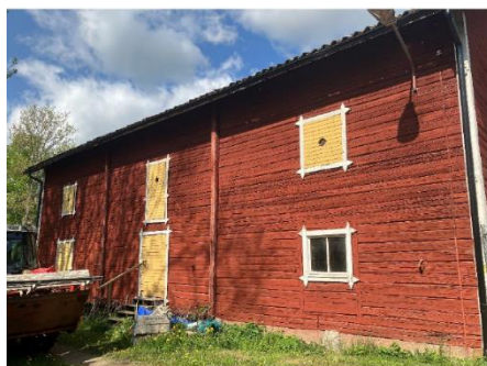
Magasinet sett från sydöst. Fönstret tycks ha ersatt en tidigare dörr.
