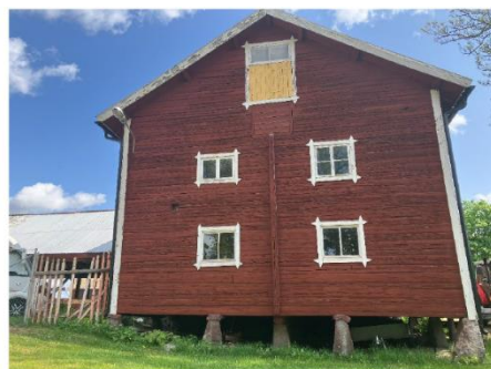
Byggnadens funktion kan avläsas i luckor och böga plintar.
