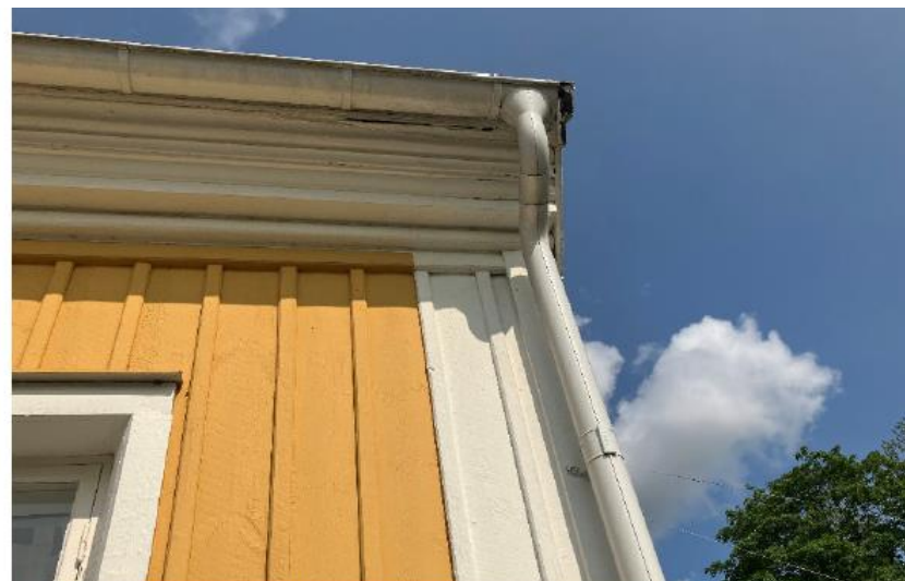
Profilerad takfot på huvudbyggnad. Djupt liggande fönster.
