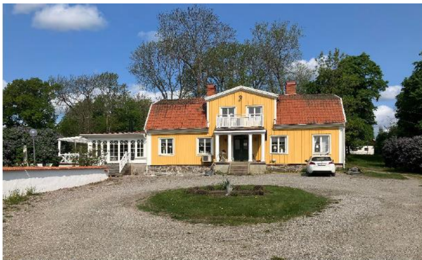
Huvudbyggnadens fasad mot sydöst.
