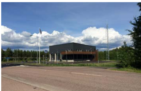
Ovan: Väse brandstation
