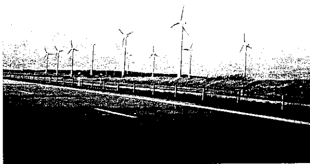
Befintliga vindkraftverk vid Falkenbergsmotet. 60 m navhöjd och 47 meters rotordiameter.
