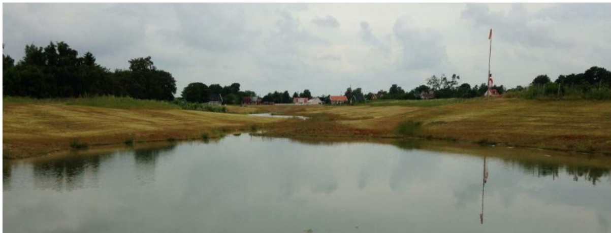
Figur 11. Bild från Projekteringsråd vid utformning av dagvattenanläggningar inom NSVA. Visar Tegeldammen i Påarp med varierande släntlutning.
