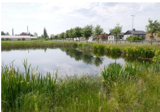
Figur 12. Bild från Projekteringsråd vid utformning av dagvattenanläggningar inom NSVA. Damm i Landskrona med Blommande svärdslior. Varierande utformning och vegetation i dammarna kan bidra till ett rekreativt promenadområde.
