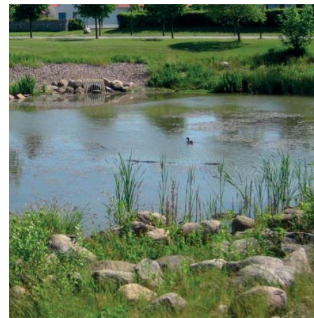
Exempel på dagvattendamm och svackdiken
