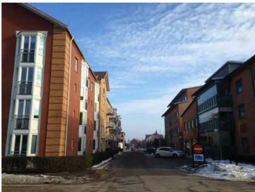
Till vänster syns Backsippans vård- och omsorgsboende som är beläget inom planområdet och till höger syns Asters vård- och omsorgsboende.
